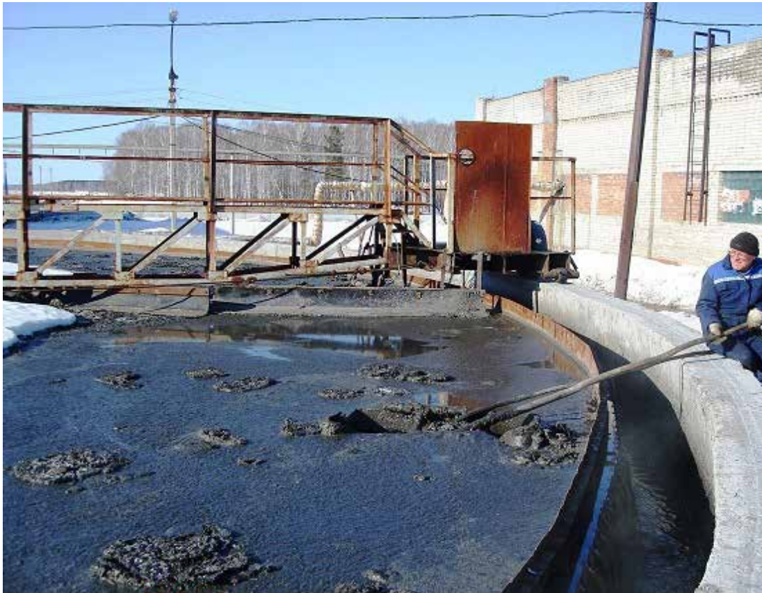
Рис. 16. Уплотнитель сырого осадка
