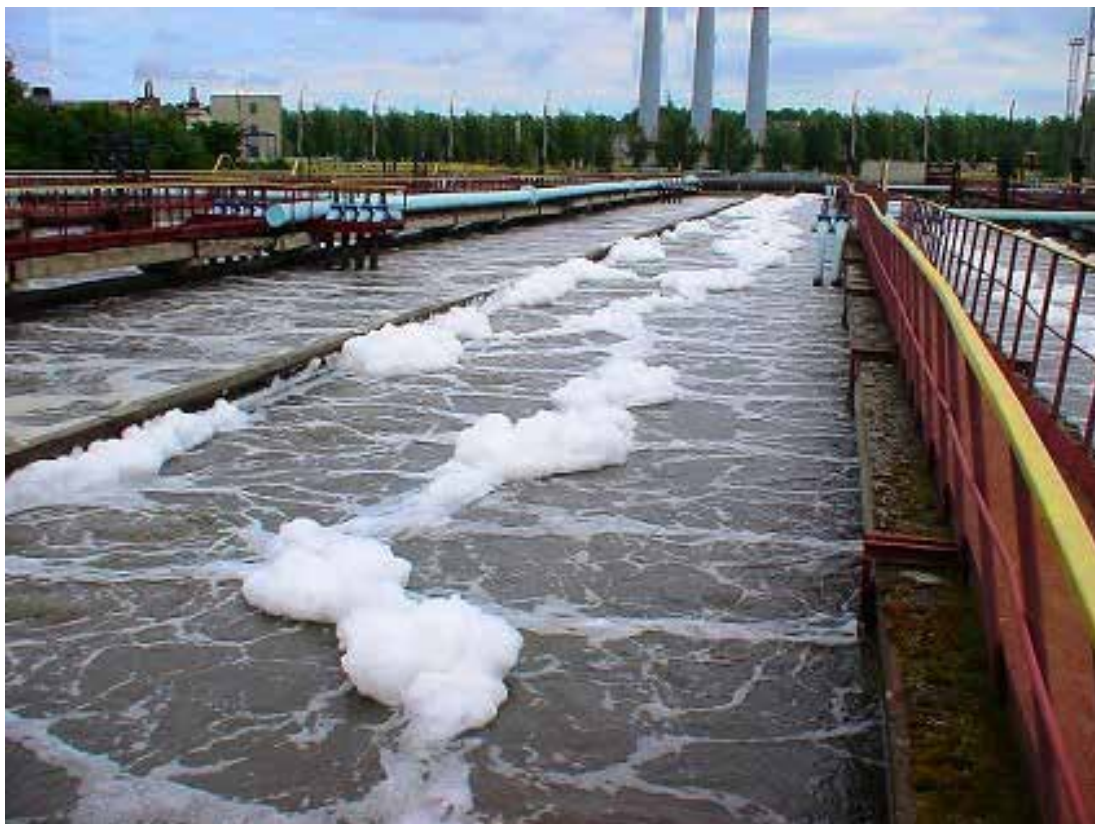
Рис. 14. Пена в аэротенках, нарушение баланса микроорганизмов активного ила, стресс-факторы, токсичные или трудно окисляемые стоки, причиной иногда является фугат/фильтрат из ЦМО (собственный архив)
