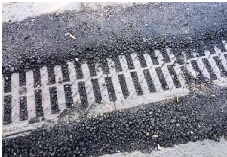
Где рис. 4? Рис. 5. Заасфальтированные люки ливневой канализации
