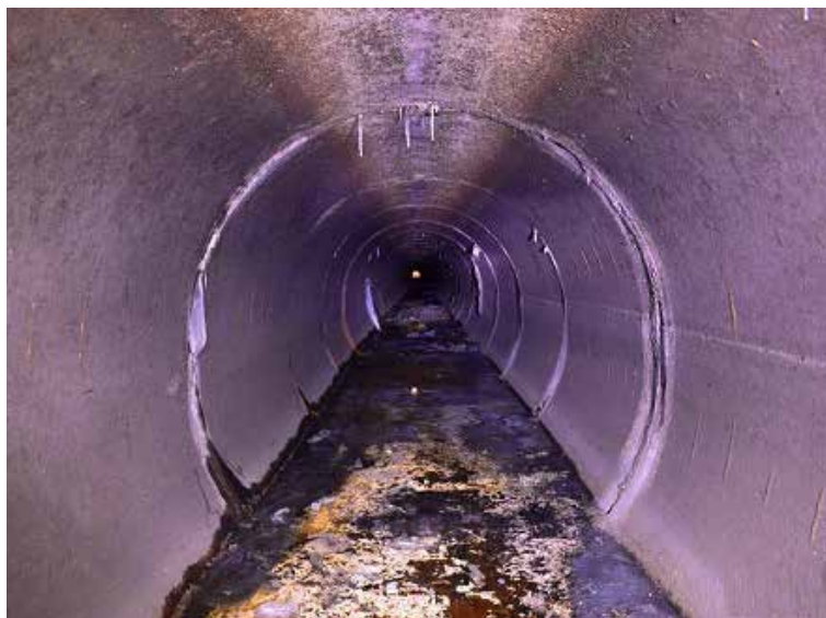
Рис. 1. Классический канализационный коллектор из ЖБИ-элементов с дурно пахнущим бродящим осадком на дне
