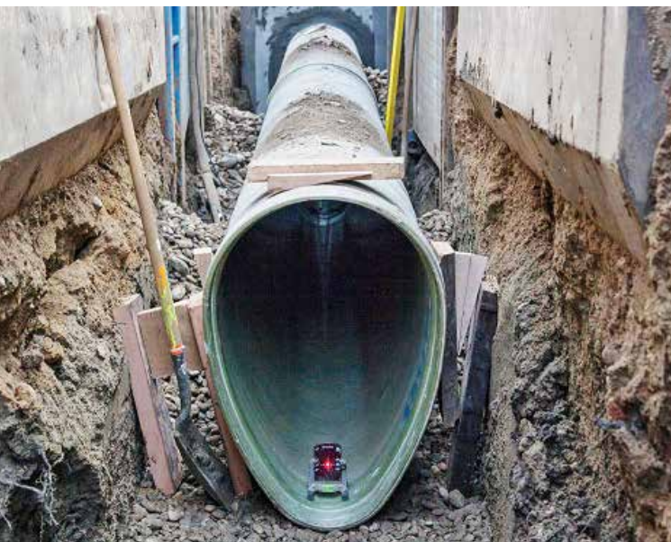
Рис. 8. Стеклопластиковый самопромывающийся коллектор в форме яйца
