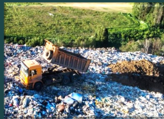
Пересыпка полигона ТБО
