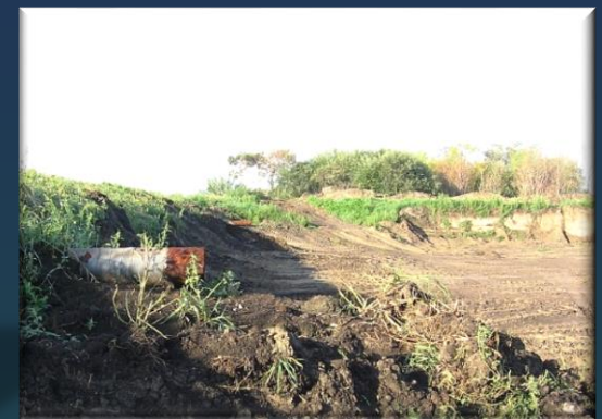
Подсушенный шлам готов к выгрузке из ЗИП
