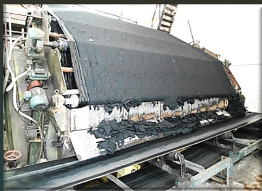
Фильтр-пресс в работе
